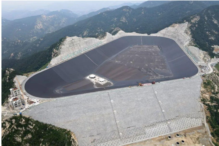
面板摊铺水工沥青混凝土效果
